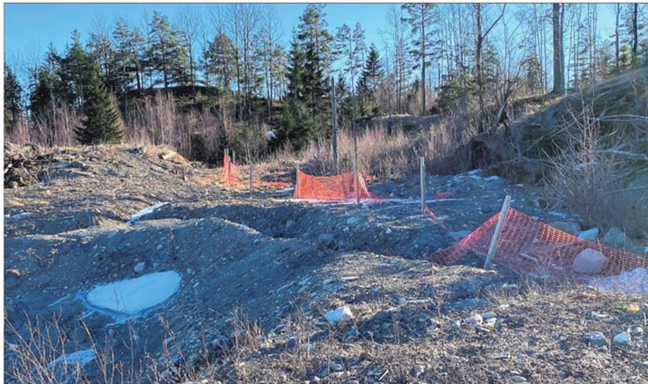
FARLIG: Mangelfull sikring av pukkverk.
