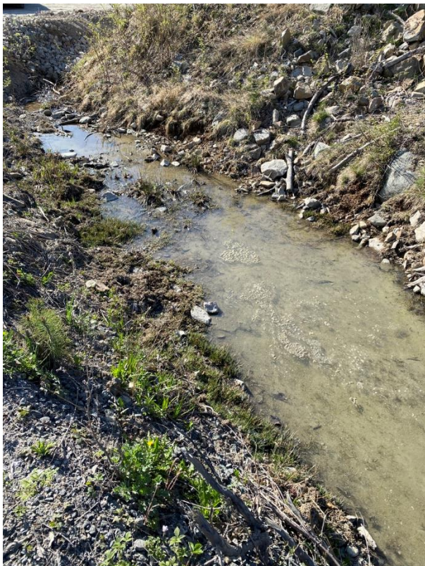
Figur 4-36: Bilde viser grøft langs veien, like nord for (oppstrøms) stikkrenne under veien.
