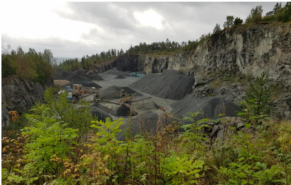
Figur 4-9: Pukkverk sett fra nord-vest. (Foto: Asplan Viak)
